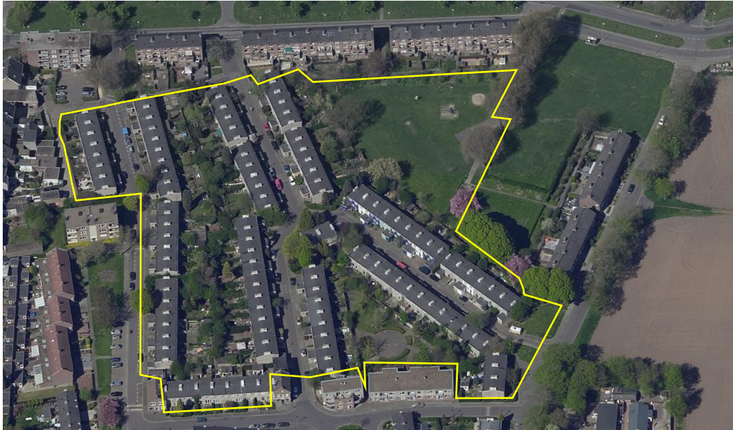
Luchtfoto in vogelvlucht van het plangebied (Streetsmart)
